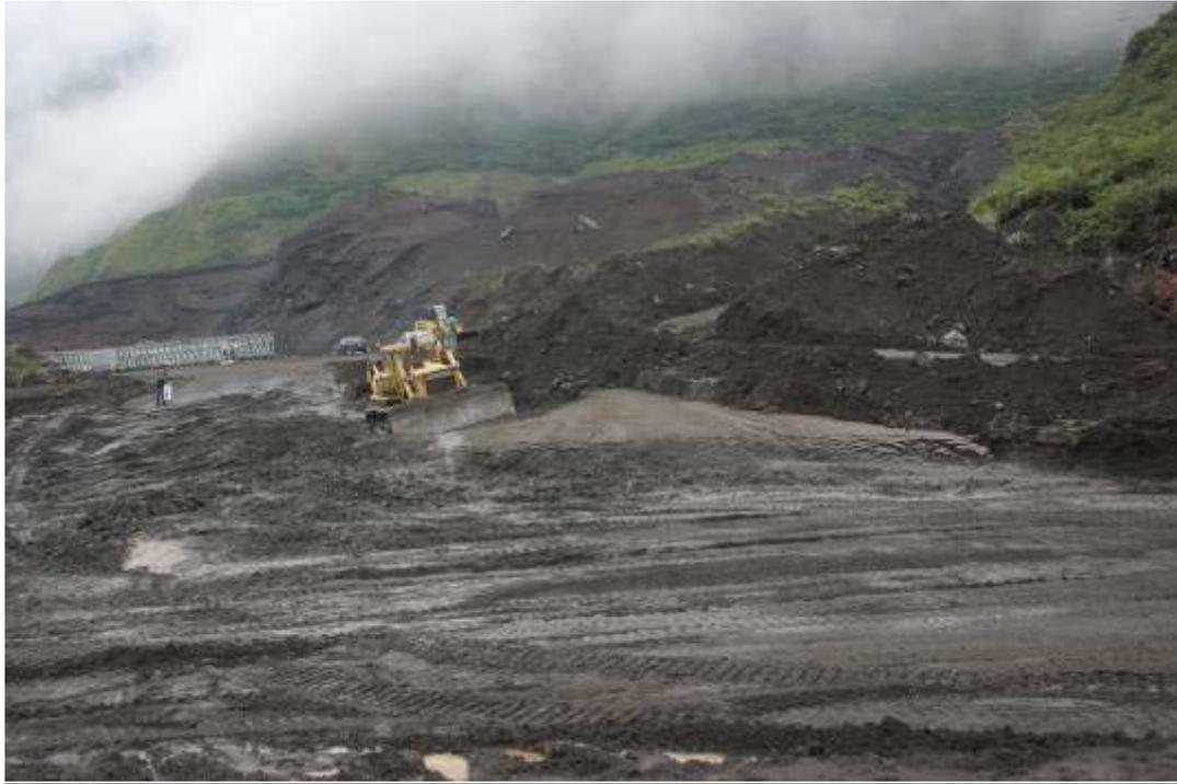
**Figura 7:** Los trabajos de limpieza de la vía en La Pampa se iniciaron en la mañana del día miércoles. Notar delante de la máquina, la altura que alcanzó el depósito del lahar (Foto: PR-IG)
