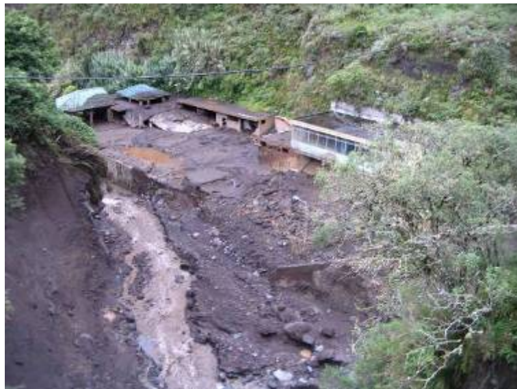
Fig. 9 Las piscinas fueron totalmente dañadas por el flujo.
