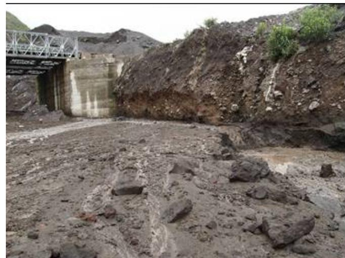
**16h50** Lahar en el puente de la Pamapa. El estribo de la margen derecha es erosionado por el flujo de lodo. Foto: G. Ruiz
