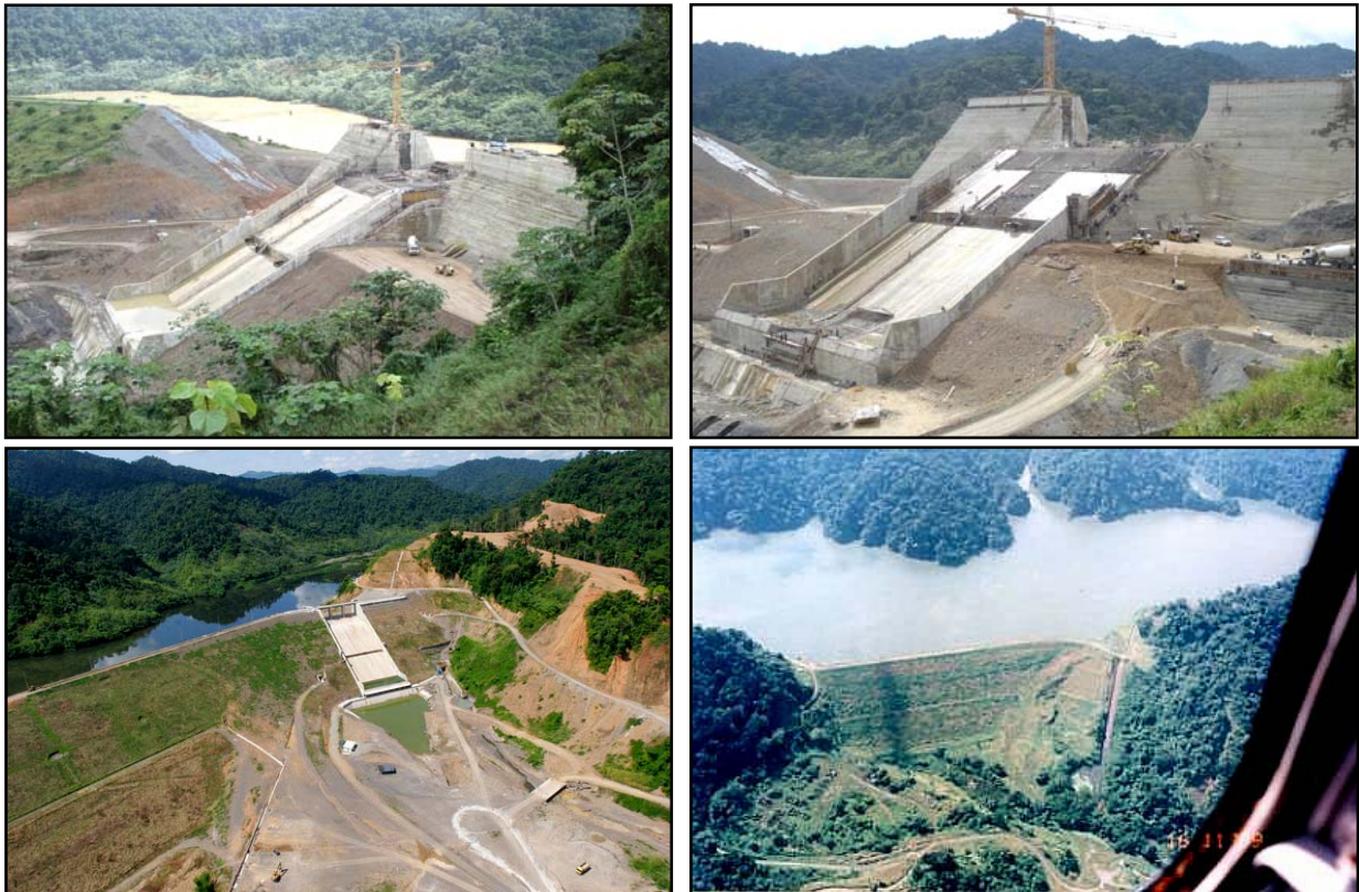
Fig. 3: Las dos imágenes superiores muestran los trabajos inherentes a la construcción y desarrollo de la nueva infraestructura hidráulica (aliviadero), iniciados en el 2003. En las imágenes inferiores, a manera de comparación, se observan (a) el nuevo aliviadero (imagen izquierda) redimensionado y (b) el aliviadero de la obra original (imagen derecha) del represamiento del río Guapo. Fotografías de HIDROVEN.
