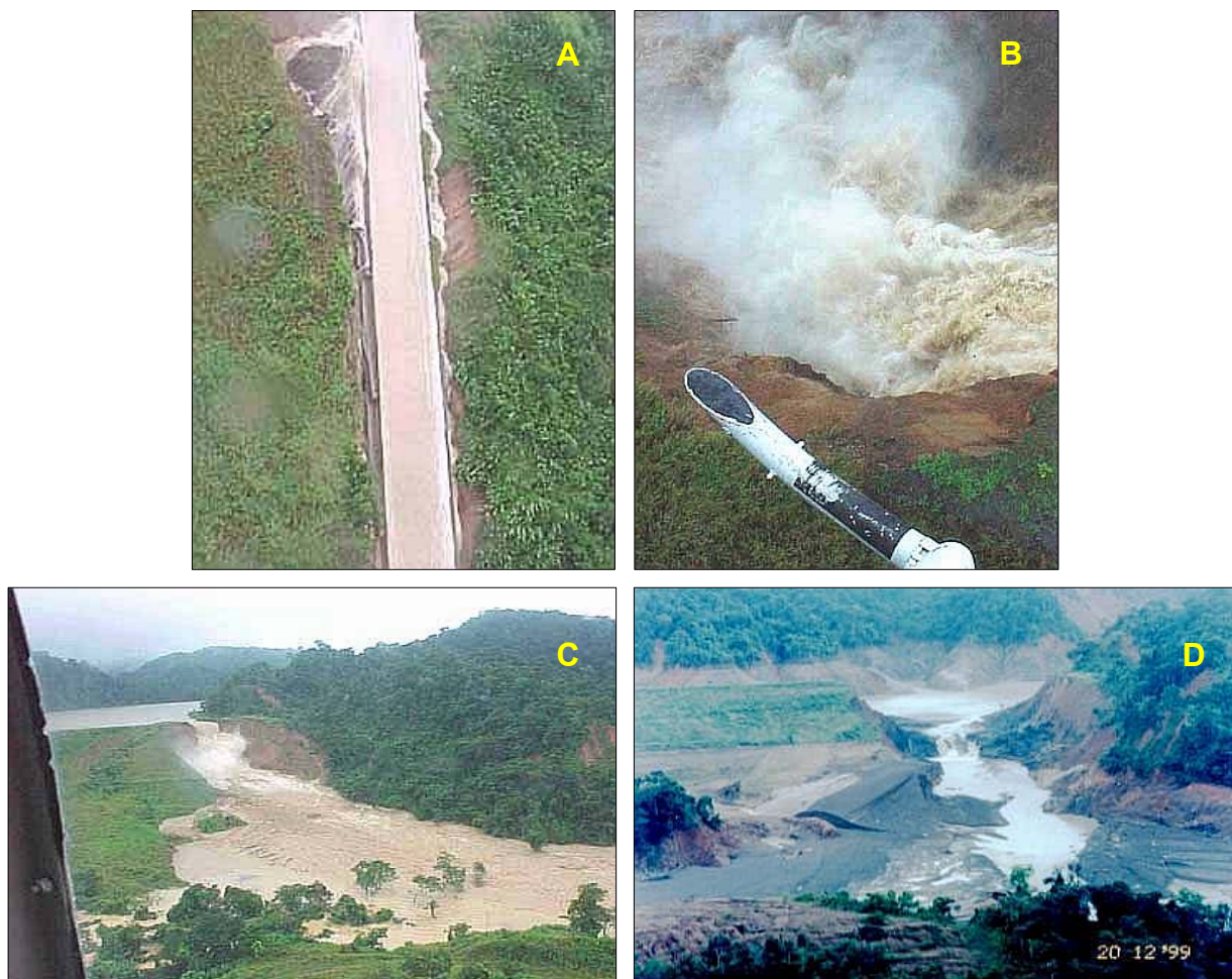
Fig. 2: Imágenes del colapso del aliviadero de la presa El Guamito en su estribo izquierdo: (a) desborde lateral del exceso de agua que circulaba por el canal del aliviadero y socavación del talud sobre el que se asentaba; (b) momento en el que el aliviadero se destruye por completo e inicia la salida de la onda de crecida; (c) vaciado del embalse a través del boquete originado por la erosión del agua posterior al colapso del aliviadero, e inundación aguas abajo del sitio de presa; y (d) boquete en el estribo izquierdo de la presa, a través del cual se observa el área del embalse vaciada en su totalidad. Fotografías de HIDROVEN.
