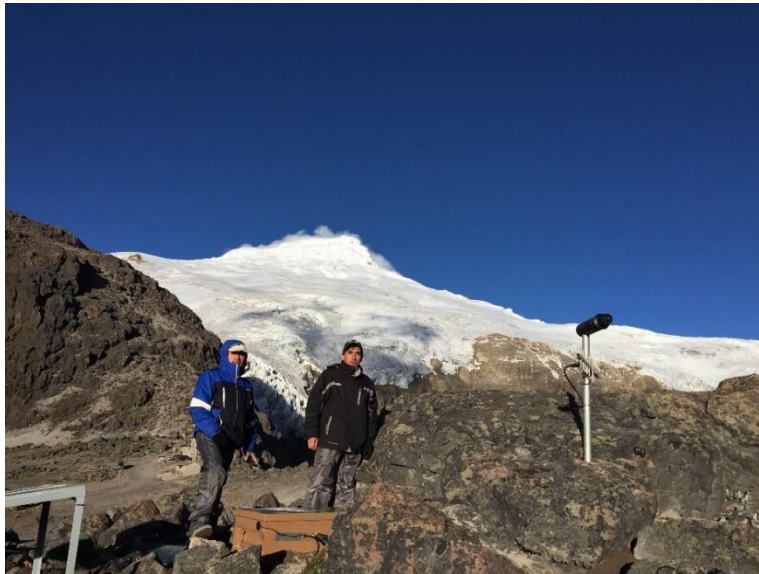
Fig 6: Instalación estación DOAS Cayambe Refugio
