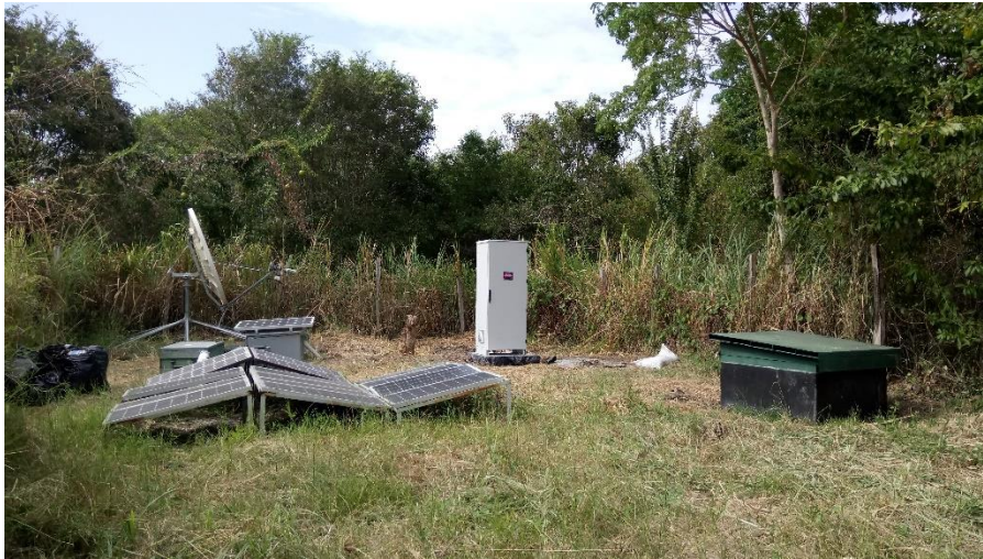
Fig. 4: Mantenimiento estación Río Verde, instalación de rack outdoor
