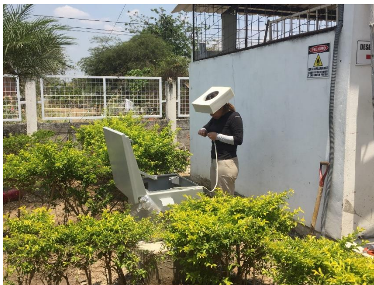
Fig 5: Instalación estación Pedro Carbo.
