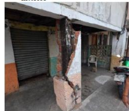
d) Columna de madera recubierta con ladrillo
