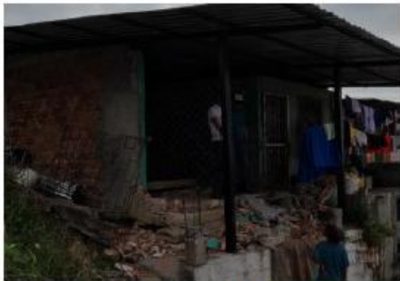
a) Colapso parcial de fachada
