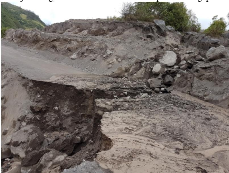
*Figura 3: Quebrada Ingapirca afectada por descenso de flujo de agua lodosa, erosionó la carretera dificultando el paso vehicular (Foto: M. Córdova, OVT/IG-EPN).*
