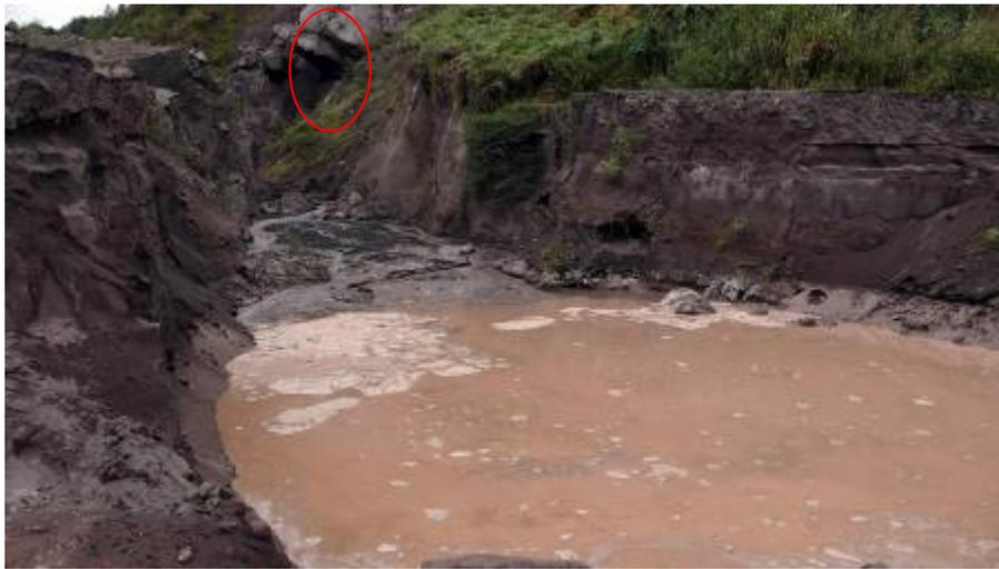
*Foto 7: Represamiento de agua en la Q. Chontapamba junto al relleno de la vía.*
